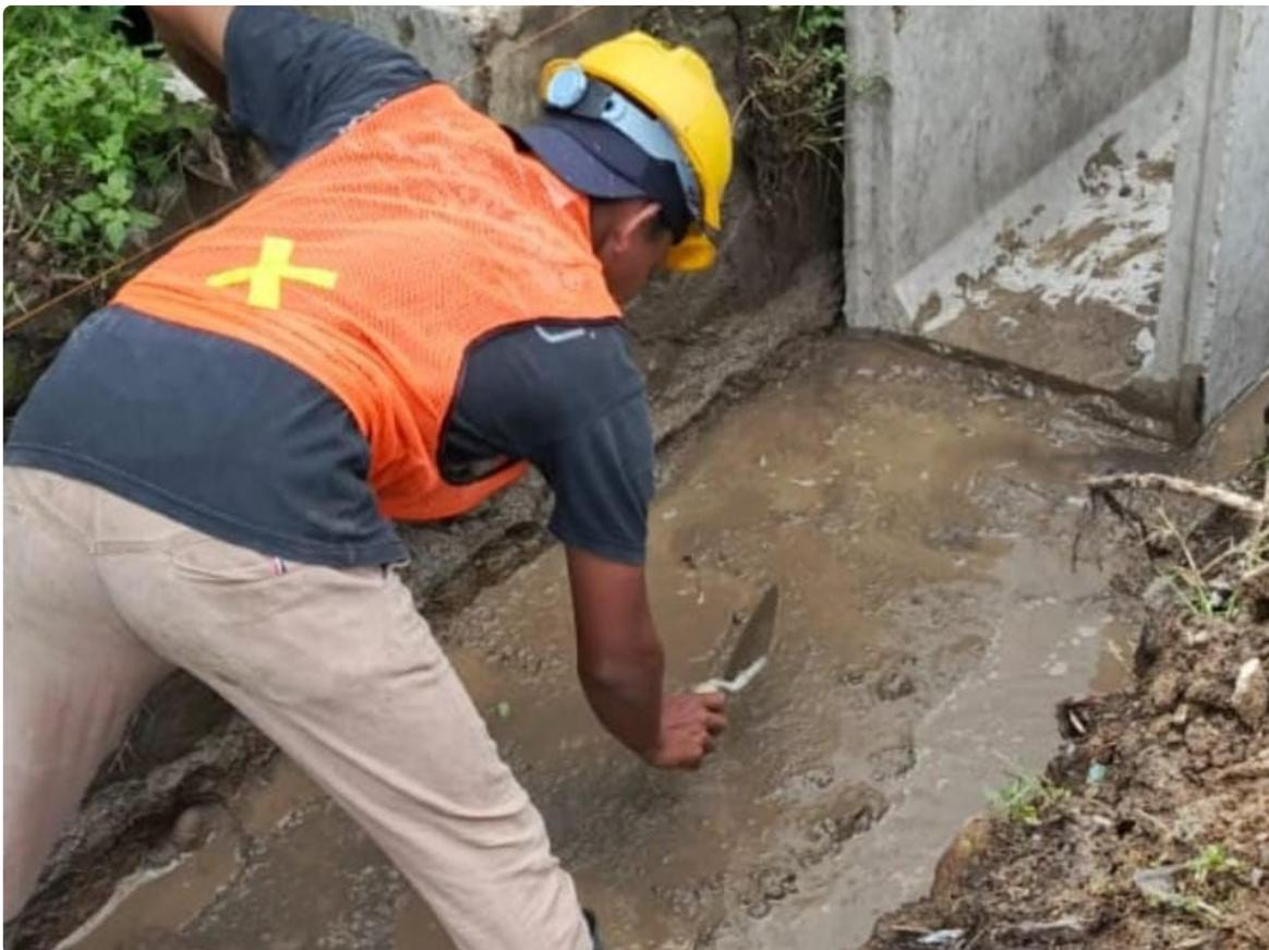
“Secara teknis, pemasangan U-Ditch harus dilakukan di atas lantai kerja dan kondisi tanah wajib kering untuk memastikan daya dukungnya. Tapi di sini justru dipasang langsung di atas genangan air. Ini jelas melanggar standar,” tegas Bayu, Ketua KCBI Jawa Tengah, saat meninjau lokasi, Kamis (13/11/2025).
