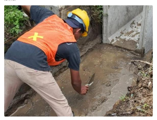
"Secara teknis, pemasangan U-Ditch harus dilakukan di atas lantai kerja dan kondisi tanah wajib kering untuk memastikan daya dukungnya. Tapi di sini justru dipasang langsung di atas genangan air. Ini jelas melanggar standar," tegas Bayu, Ketua KCBI Jawa Tengah, saat meninjau lokasi, Kamis (13/11/2025).
